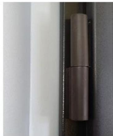
Fig. 1 (di serie) La struttura interna dell'anta (battente mobile) è in acciaio galvanizzato, presso piegato. All'interno, trovano alloggio i rinforzi orizzontali e verticali a forma di "Omega". Il battente mobile, viene poi accoppiato al telaio per mezzo di due cerniere in acciaio coperte con cappucci in plastica dello stesso colore delle modanature della porta (Fig. 2).
