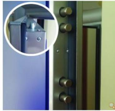
Fig. 1 (di serie) Doppia serratura con doppio cilindro europeo e deviatori con quattro catenacci superiori e quattro inferiori nonchè un perno posto nella parte superiore dell'anta (Fig. 2).
